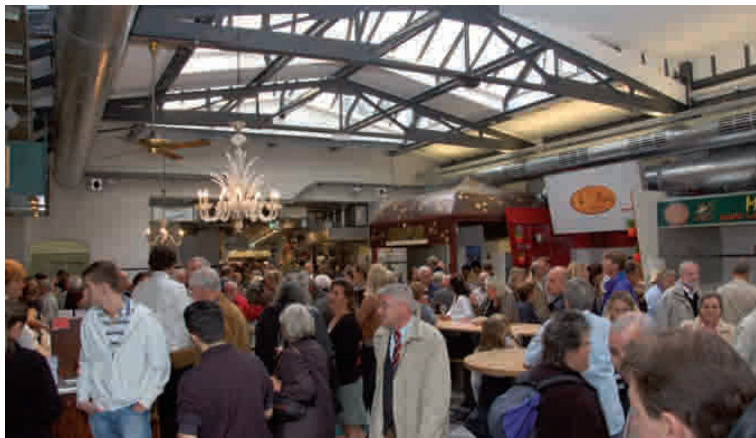
Durch das Glasdach gelangt viel Licht in den zentralen Bereich der Markthalle.
